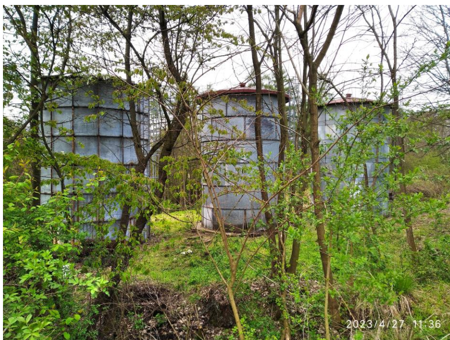
Fot. 20 Zbiorniki na wodę wybudowane na wzniesieniu do grawitacyjnego nawadniania upraw sadowniczych i celów bytowych.
