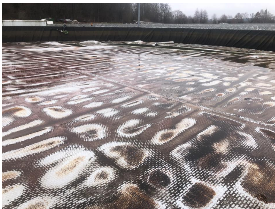
Basen na deszczówkę przykryty jest pływającą folią, aby nie dopuścić do rozwoju glonów i zanieczyszczenia wody.
