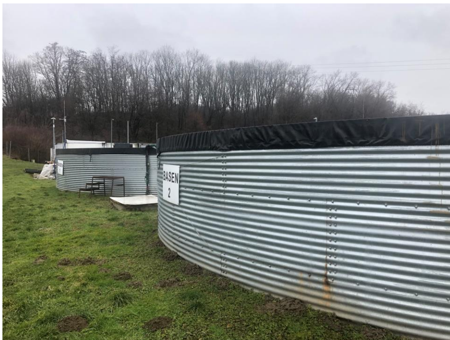
Baseny na deszczówkę, to drugie źródło zaopatrzenia roślin oprócz wody z wodociągu.
